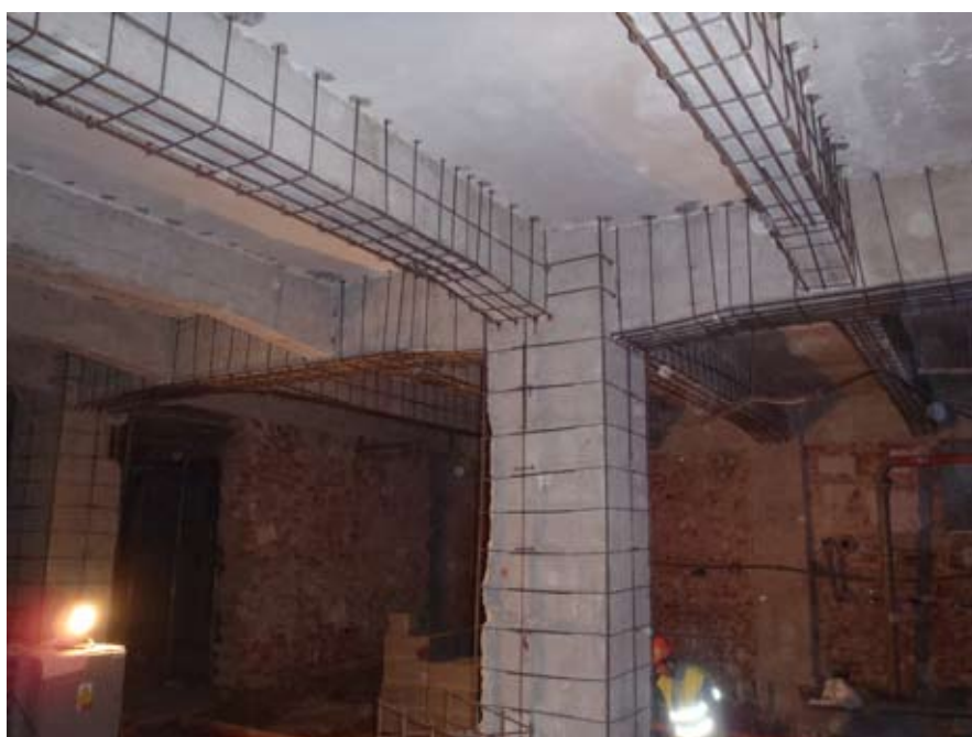
Statické zesílení konstrukce – mechanické kotvení
