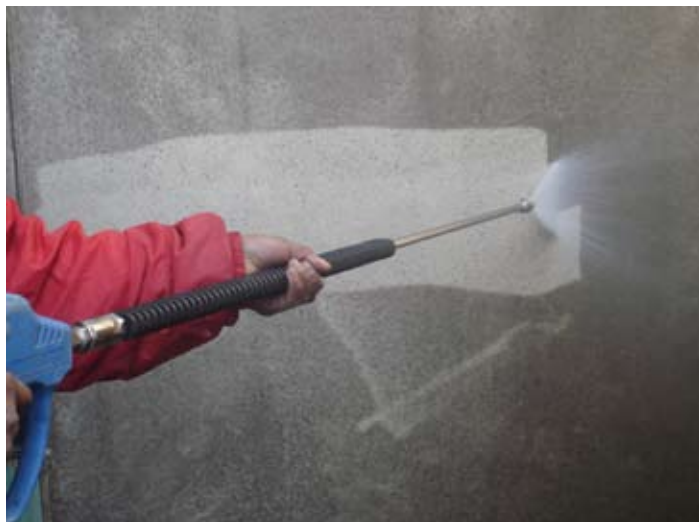
Čištění podkladu tlakovou vodou
