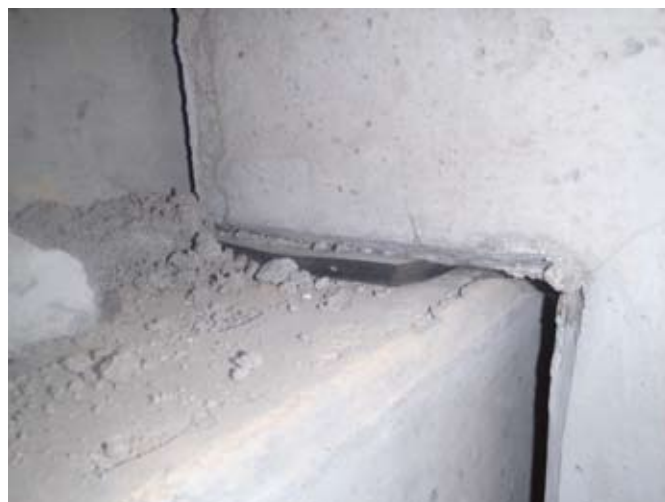
Uložení průvlaků na ozub
